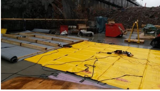
Figur 2.1.4 Mattor (gula) och isolering (grå) utlagda på bottenplattan vid försök 1. De västra mattorna täcktes med 10 mm betongtäckmatta.
