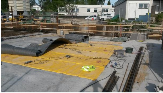
Figur 2.1.7 Värmemattorna vid utläggning innan de täcktes med isolering, försök 4.
